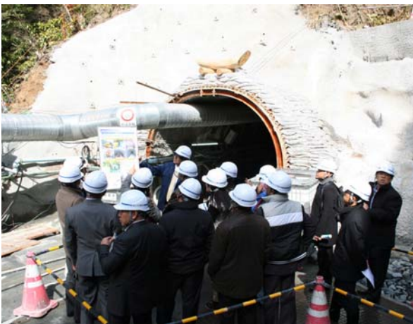
排水トンネル工事を視察するマレーシア政府関係者
