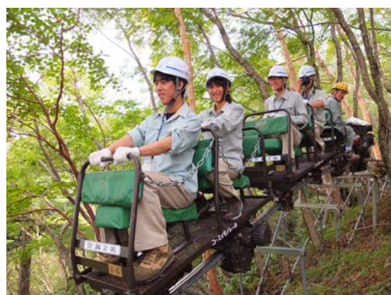
モノレールにて対策工事現場へ
