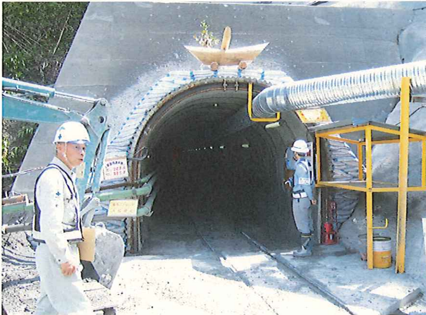
トンネル坑口
