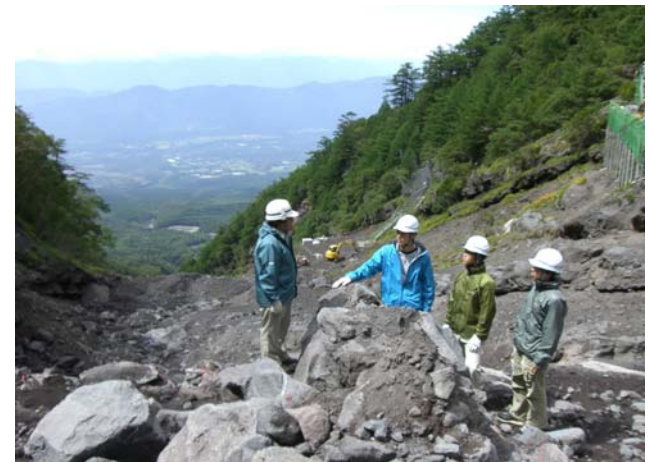
富士山大沢崩れで源頭域調査工事を見学
