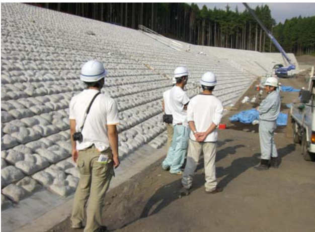
大久保沈砂地工で砂防施設工事を見学
