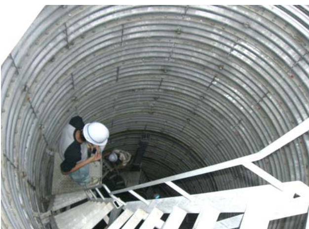
由比地すべり地区で集水井を見学
