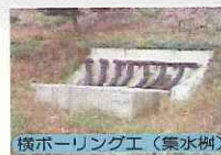
横ボーリング工(集水樹)
