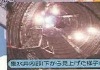
集水井内観(下から見上げた様子)
