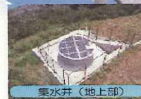
集水井(地上部)
