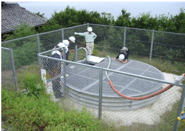
由比地すべり地区で 地すべり対策工事を見学
