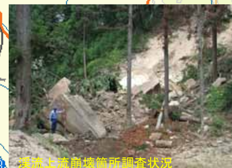
渓流上流崩壊箇所調査状況
