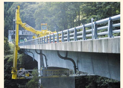
写真-1 橋梁点検車による点検の様子
