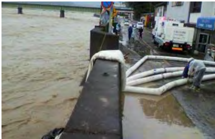
排水ポンプ車による排水支援活動 (三重県南牟婁郡紀宝町)
